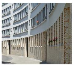
1. Bauabschnitts sind die Häuser des Schwarzwaldblocks als Dreispänner konzipiert. Die beiden Mehrzimmerwohnungen sind nach beiden Seiten, das kleinere Appartement ausschließlich zum Hof hin orientiert. Die weitgespannten Stahlbetondecken gestatten im Bedarfsfall die Verkleinerung oder sogar Aufteilung der kleineren Wohnung zugunsten der beiden anderen Wohneinheiten. Damit ist zukünftig ein flexibles Mehrgenerationenwohnen möglich.
